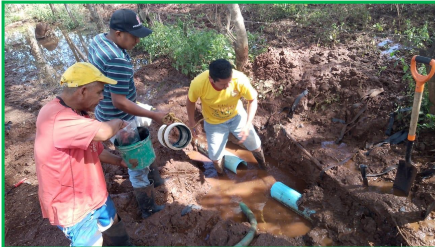
FEBRERO. SE TERMINARON LOS TRABAJOS DE REPARACIÓN DE FUGA EN EL TUBO PRINCIPAL DE 6" EN POBLADO EL COLORADO
