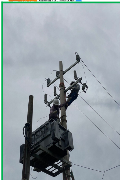
INSTALACIÓN DE UN TRANSFORMADOR NUEVO EN LA SUBESTACIÓN ELÉCTRICA DEL ÁREA DE BOMBEO
