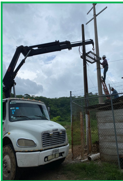
INSTALACIÓN DE UN TRANSFORMADOR NUEVO EN LA SUBESTACIÓN ELÉCTRICA DEL ÁREA DE BOMBEO
