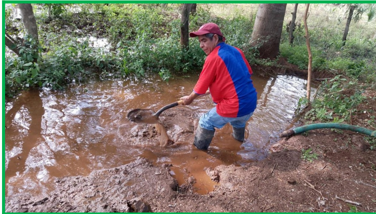
DESAZOLVE DE LA TUBERÍA PRINCIPAL DE DRENAJE, EN CALLE 20 DE NOVIEMBRE, COL. LA ENCANTADA.
