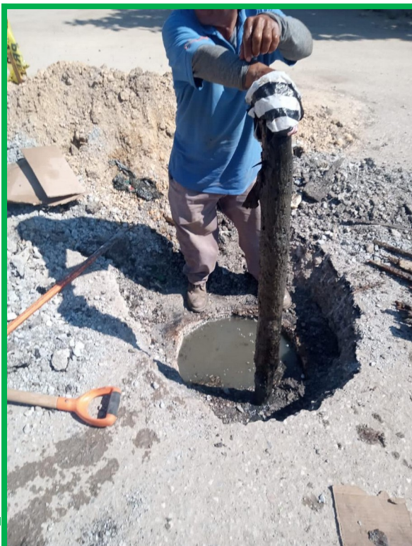
FEBRERO. DESAZOLVE DE DRENAJE TAPADO CALLE 12 OCTUBRE COLONIA LA ENCANTADA.
